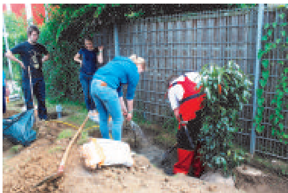
Beton für die Carportfundamente.
